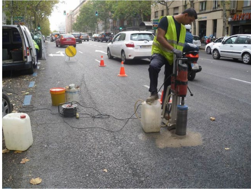
Figura 6. Fotografía de la extracción de un testigo
